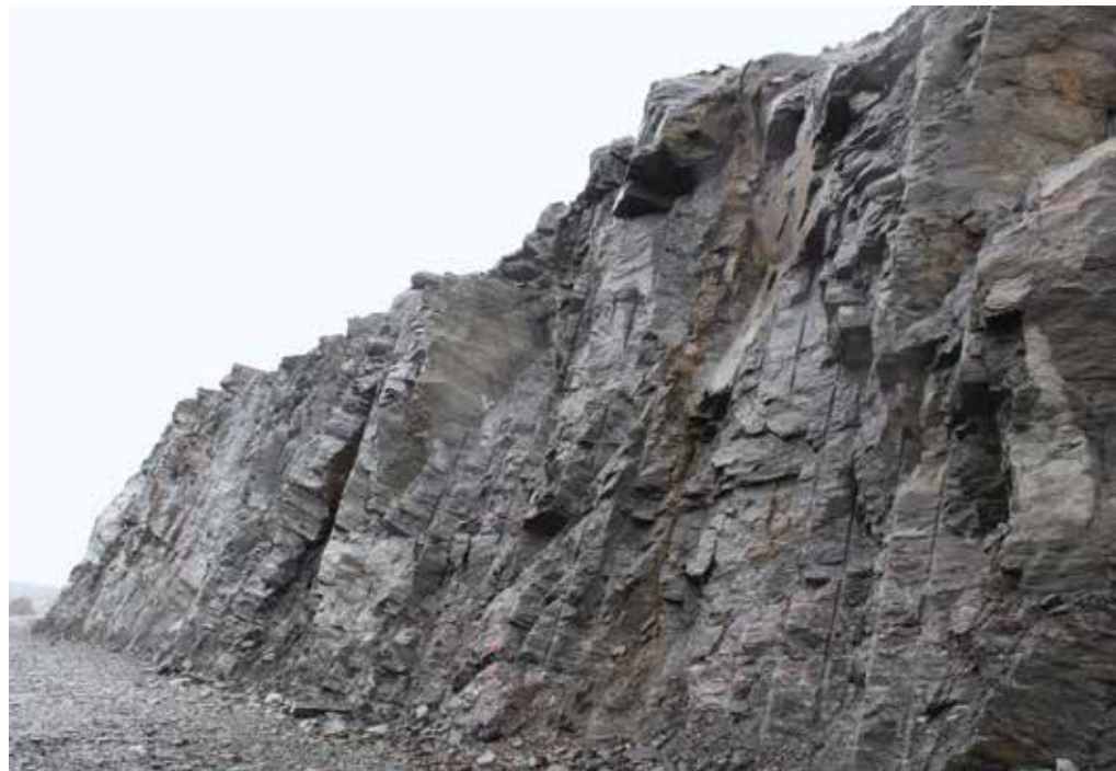
Skärningen som i dagsläget sträcker sig cirka 100 meter in, har på sina ställen taggar av berg som sticker ut över tre meter för långt.
