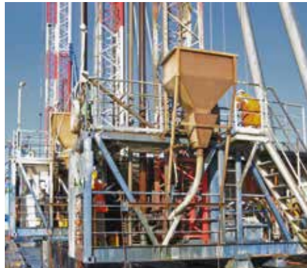
Foto: Van Oord Capitol 45-01 i position för borrning av sista raden alldeles intill den känsliga kajkanten. Nu gäller försiktig sprängning.
