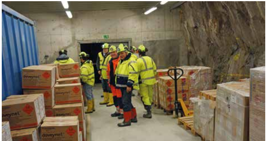
EPC som sköter laddningen har sprängmedelsförråd under jord.
