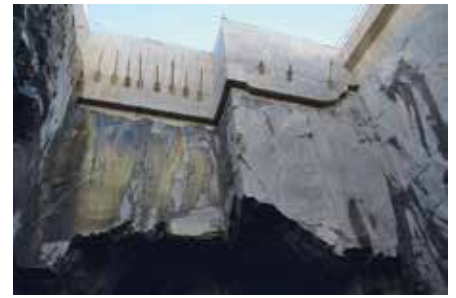
Projektet vid KVV8, Värtaverket.
