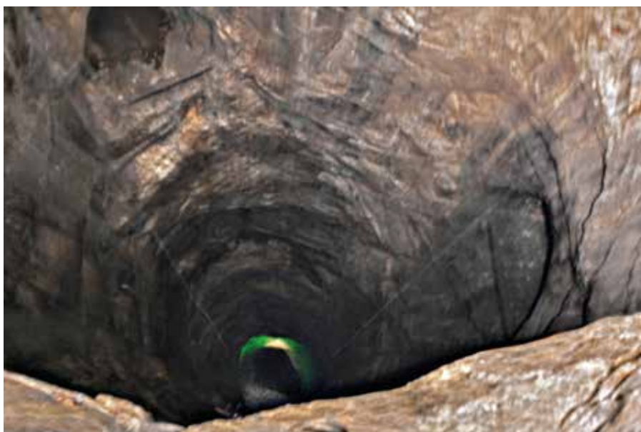
Drottning Christinas imponerande schakt som påbörjades 1650 innebar en andra storhetstid för gruvan. Djupet är 257 meter. Vattenytan som syns ligger på 155 meter.
