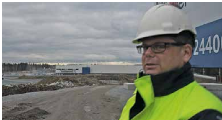
Micke visar upp arbetsplatsen i Brunna norr om Stockholm. Kilenkrysset ska här bygga ett stort industriområde.
