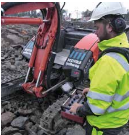
Andreas Gundersen kör Sandviks DC400Ri borrarregat med fjärrkontroll utrustad med fjärrdisplay.
