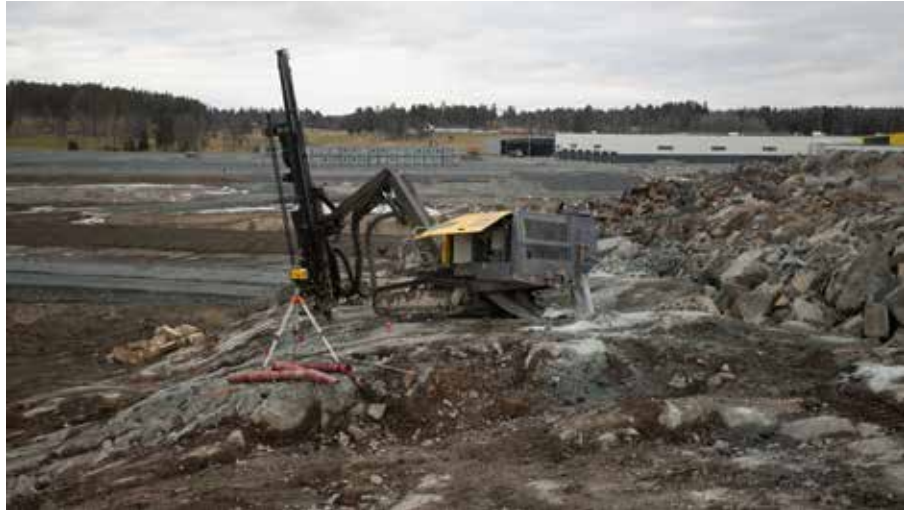
Arbetsplatsen i Brunna. Berg och Bygg har borrhagnar från Sandvik och Atlas Copco.
