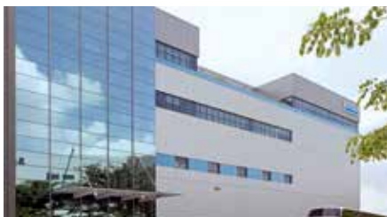
Sandviks nya logistiska centrum är byggt med hjälp av den senaste teknologin, miljö- och energimässigt.
