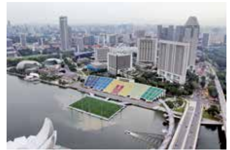
Världens enda flytande fotbollsstadion, 120 x 83 meter. Den är genomgående av stål och klarar vikten av 9000 personer. Läktaren har 30 000 sittplatser. Arenan är avsedd för alla typer av kulturella evenemang.
