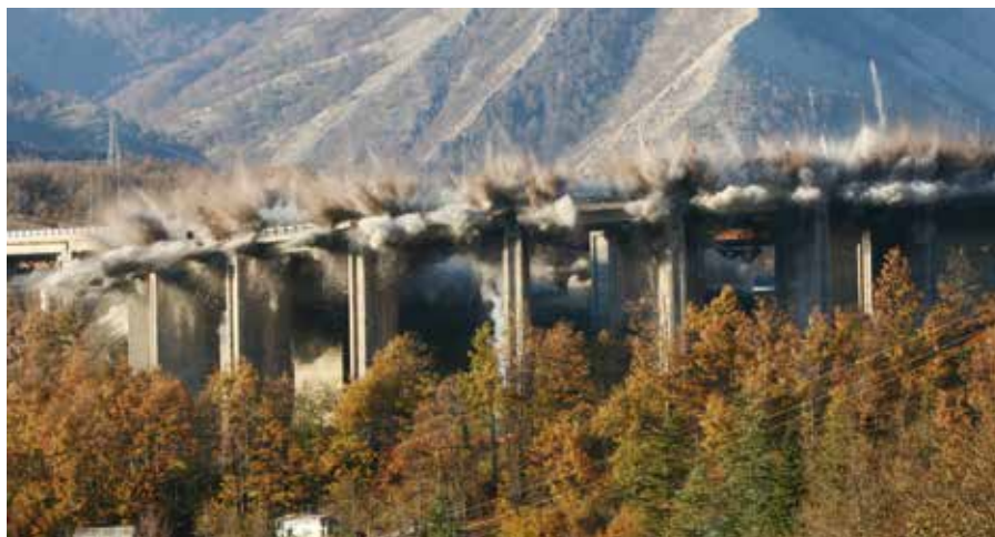
Demolering av broar är ett vanligt uppdrag för Nitrex
