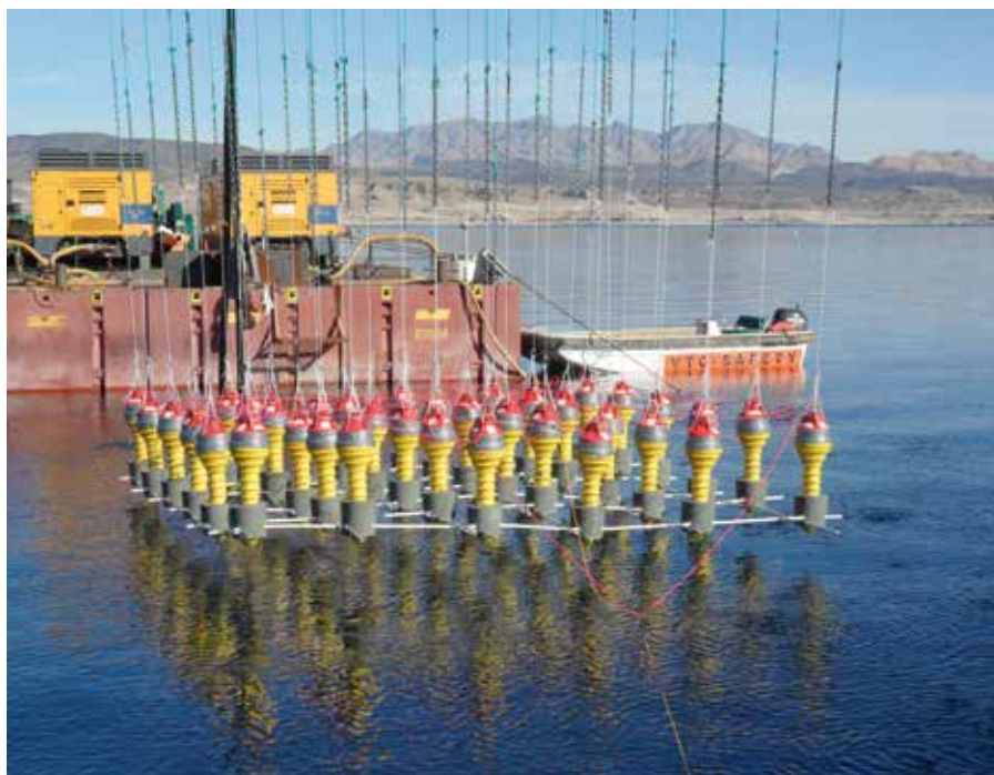
Den specialdesignade utrustningen som krävdes för sprängningen på 110 meters djup
