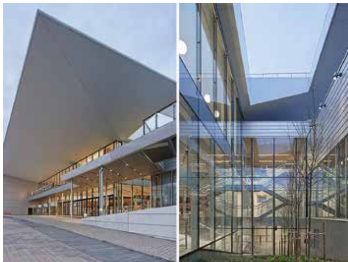
Stockholmsmässans nya huvudentré, byggd i betong och stål, har försetts med stora glasytor som ger ett luftigt dagsljusinfall. Den skuggande utkragningen på 16 meter lyser kvällstid upp i olika färger.
