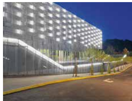
Stockholmsmässans AE-hall är byggd i betong och stål. Betongstommen omges av ett flätverk av metall, som både dagtid kvällstid ger en tydlig reliefverkan.
