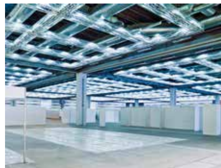
Vänstra bilden: Närbild metallflätverket. Högra bilden: Rumshöjden varieras med hjälp av höj- och sänkbara belysningsriggar. Flyttbara betongväggar hänger i takbalkarna.
