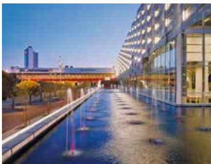
Stockholmsmässans AE-hall är byggd i betong och stål. Betongstommen omges av ett flätverk av metall, som både dagtid kvällstid ger en tydlig reliefverkan.
