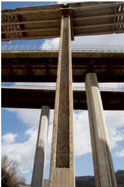
Närmast pelarna är betongen borttagen och med en hydraulhammare har man kapat loss däck som nu bara hänger i balkarna.
