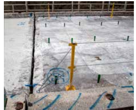
Däcket rakt och fint kapat med diamantsåg.
