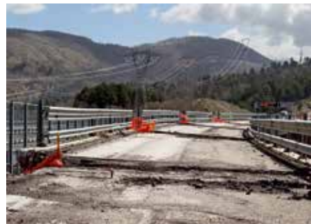
Gamla bron sedd uppifrån vägbanan.
