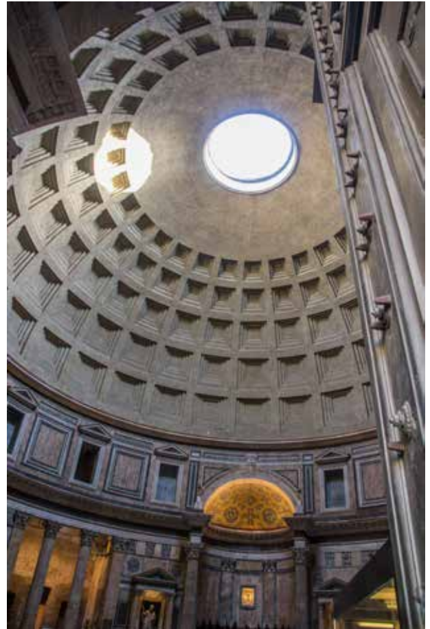
Ett bevis för att betong är hållbar är det antika templet Pantheon vid Piazza della Rotunda, världens äldsta byggnad som fortfarande är i bruk.
