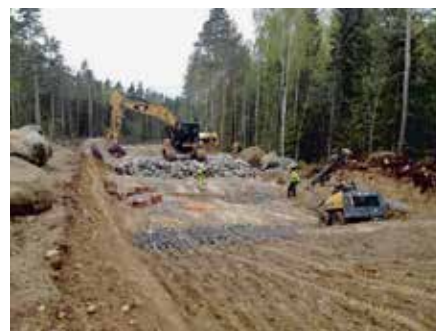
Väggbygge, fortsättning Skottvägen i Örebro.
