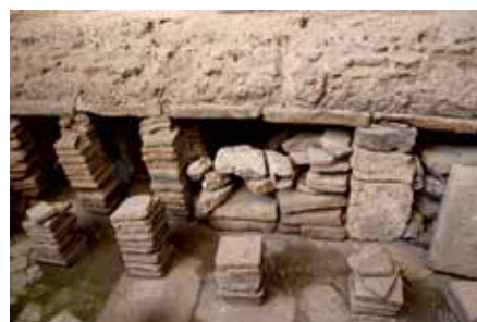
I badhuset hade Pompejiingenjörerna installerat ett avancerat system för golvvärme.
