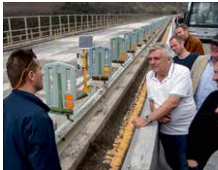
Viadotto Italia. Bara tio centimeter mellan nybyggda bron och den som ska sprängas.
