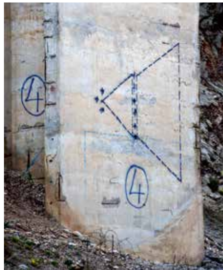
Bilningen och sprängningen av pelarna kan jämföras med fällhugg.
