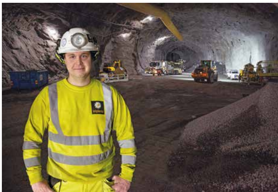
Johan i den blivande bussterminalens vänthall med spännvidd 24 meter. Terminalen med sina många entréer och anslutningar blir en central del av kollektivtrafikens nya lösningar runt Slussen.
