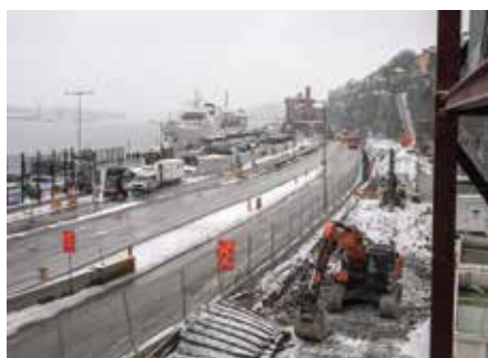
Mitt emot Birkaterminalen förbereds sprängning för en av kajplans tre entréer.
