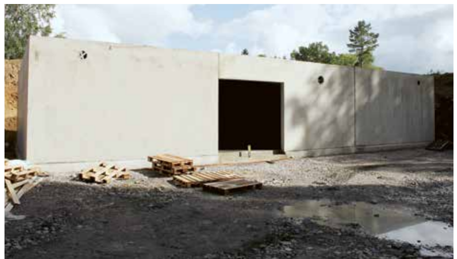
Förrådet är omringat av en hög jordvall, som ska höjas ytterligare någon meter, som skydd.
