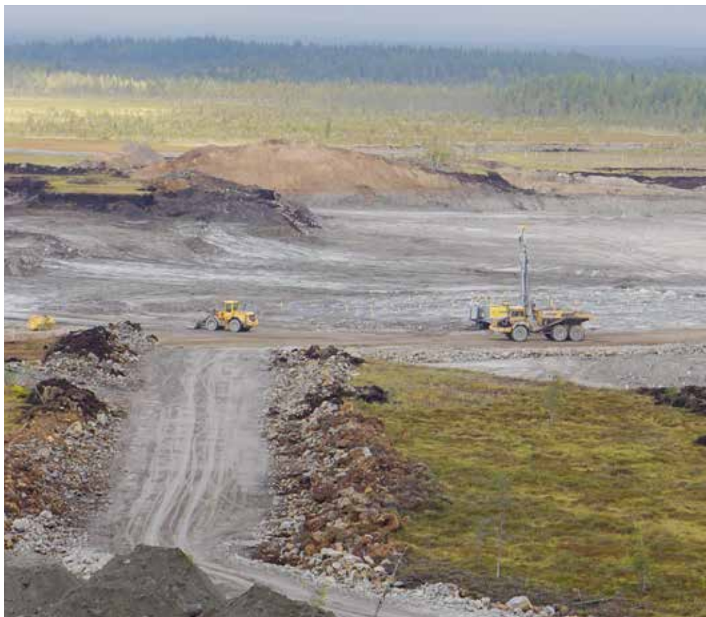
Borrigar på plats och avtäckning pågå.
