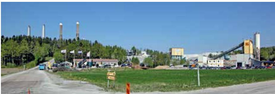
Ballasts anläggning i Stenungsund med förkrossen i mitten, utlastningen med vindsiktsanläggningen till höger och grannföretaget Färdig Betong längst till höger. I bakgrunden syns skorstenarna från det underjordiska oljekraftverket som från början orsakade att bearbetningen förlades hit 1955. Det lossgjorda bergmaterialet vid byggandet tog 15 år att krossa. Turbussen till vänster förde publiken till bergtäkten där också en mängd aktiviteter pågick.
