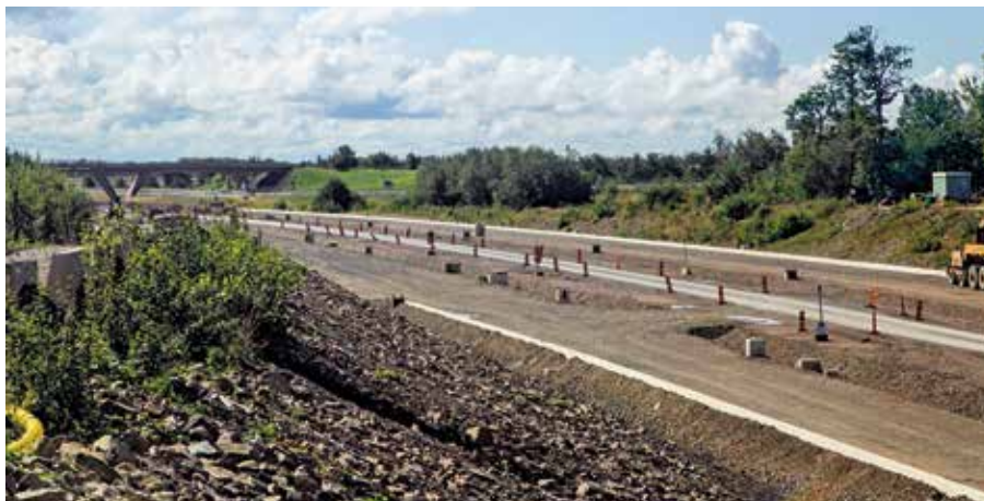
Här, några hundra meter från södra tunnelmynningen, ska Förslövs station byggas. Området där de 40 000 tunnelsegmenten lagrades blir parkering.
