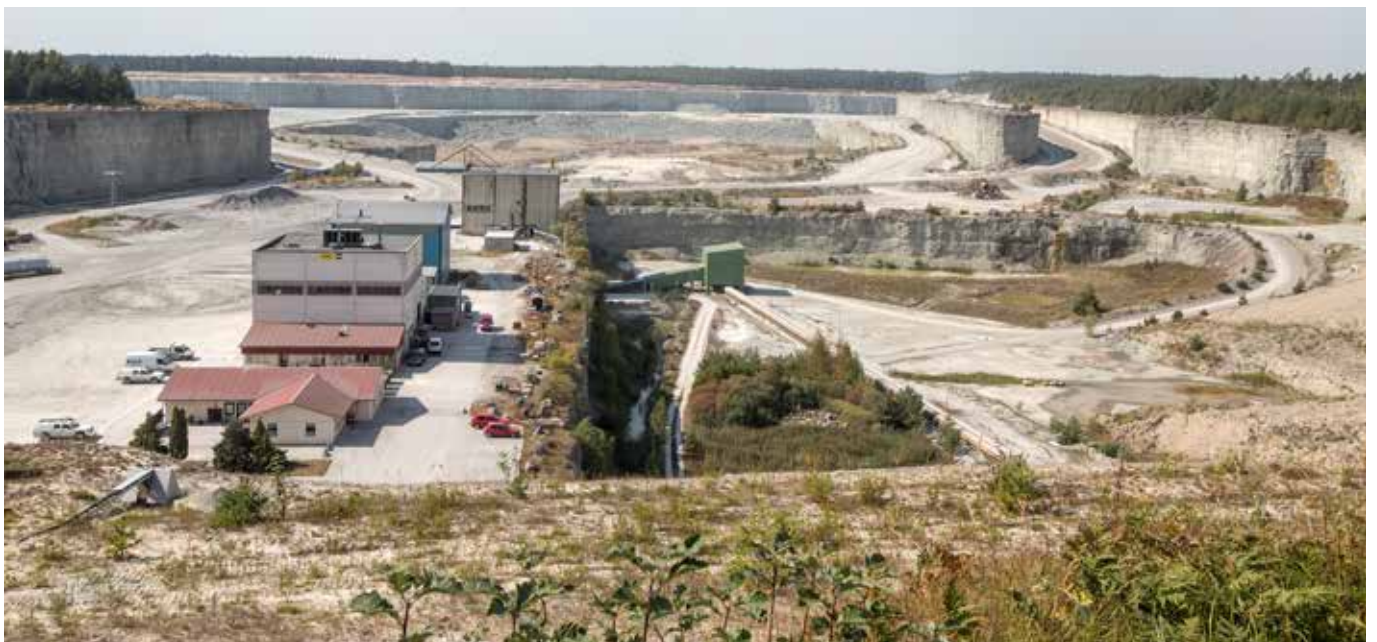
Efter väg 147 vid Slite finns en utsiktsplats över Cementas Västra Brott där brytningen nu närmar sig sitt slut och återfyllningen påbörjats. Täkten har en förbindelse under vägen till sortering och fabriksanläggning
