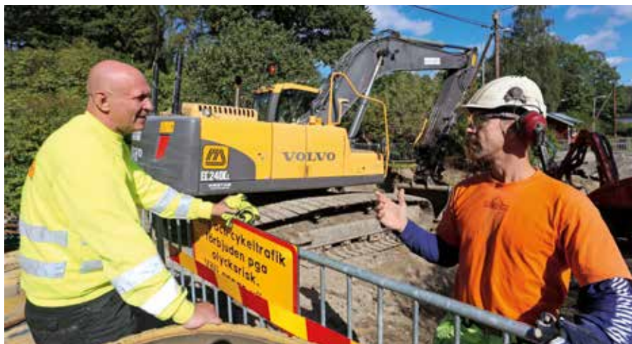
Christer och Fredrik Ekström byter några ord vid arbetsplatsen på Högmoravägen i Huddinge. Vatten och avlopp ska fram till fastigheterna och nya vägar ska anläggas.
