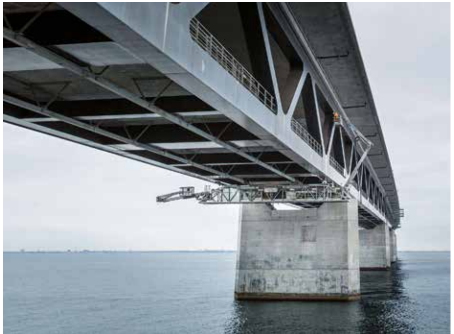
Efter 16 år är det dags att måla om stålfackverket kring Öresundsbrons tågäck. Minst 320 miljoner kronor beräknas kalaset kosta.
