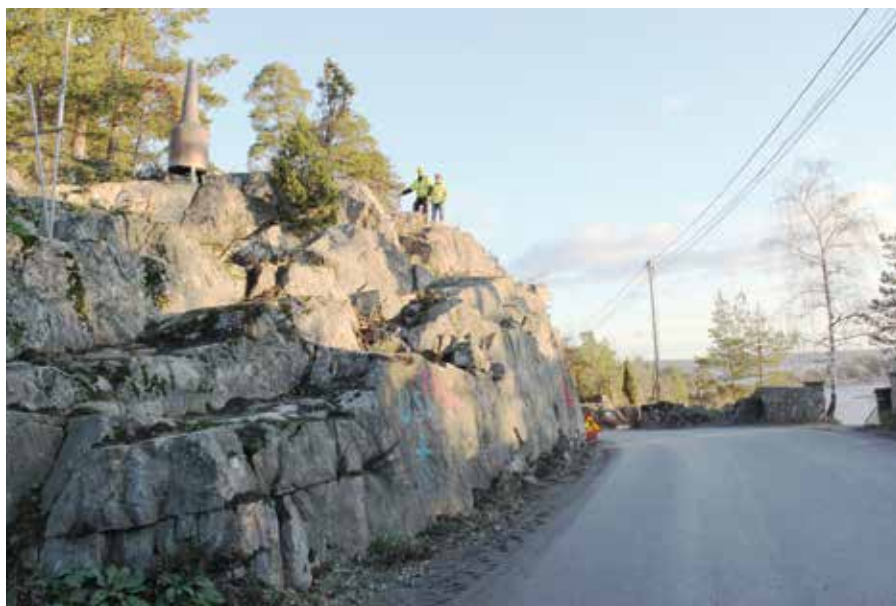
En av skärningarna där berget ska bort. Det ligger hus både på ovan och undersidan av vägen. Plus att den smala vägen i sig inte får blockeras.
