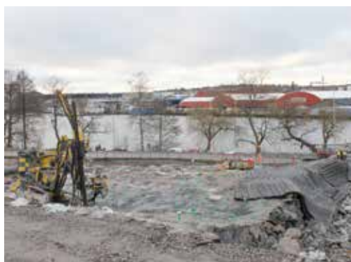
Det stora jobbet Enjis har just nu är vid Hamngatan i Sundbyberg. Där ska det byggas fyra huskroppar, väg och avlopp. Vattenledningarna som ligger i marken har konstigt satta vibrationsvärden, 20 mm på 800 ledning. Det är en stödklack gjuten i marken med riktning mot rören som ligger på trasigt berg. – Vi får väldigt stora värden. Hur vi än gör, är vi skyldiga i en sådan situation. Men det blev högre vibrationsvärden när de med padden än vi hade på salvan, reflekterar Nisse.
