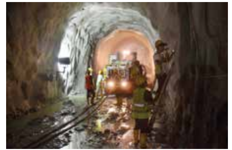
Atlas Copco, som driver 11 kilometer av tunneln, har fyra högteknologiska Rocket Boomers som arbetar parallellt på de olika delsträckorna.
