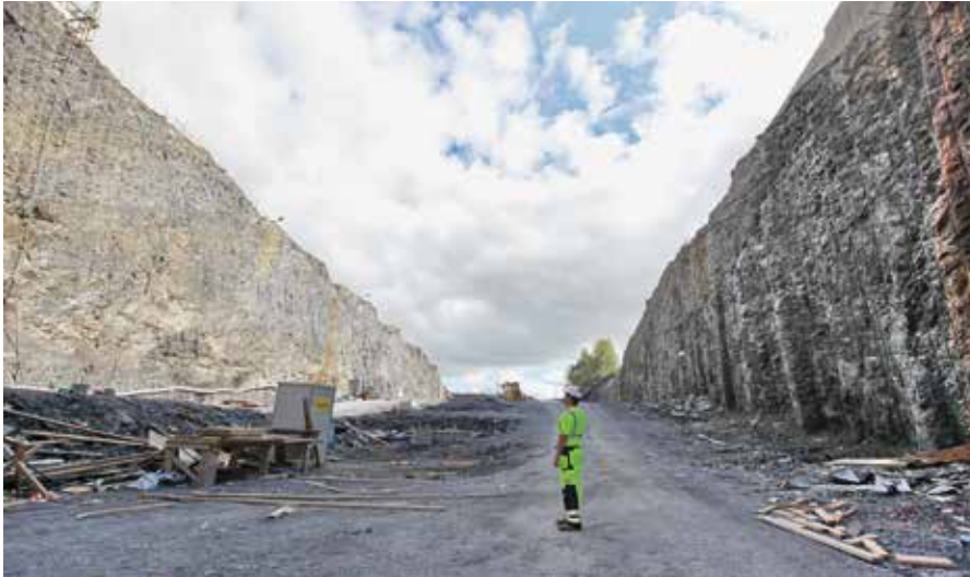
NCC Roads sprängde utloppskanalen sommaren 2011. Lägsta punkten 41 meter under vattenytan nåddes i oktober. Sedan november 2011 pågår 14 månaders intensiv betonggjutning. Bilderna tagna den 18 juli 2012.
