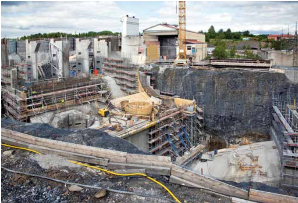
Foto från den 18 juli 2012. Längst uppe till vänster intagspelarna. Gjutningsarbeten pågår intensivt för de båda aggregaten. Vid aggregat 6 längst bort i bild ser man formerna för spiralen och längst ned sugröret som går fram mot sugrörsvallen som byggs upp längst till höger. Den blir dammvägg nedströms
