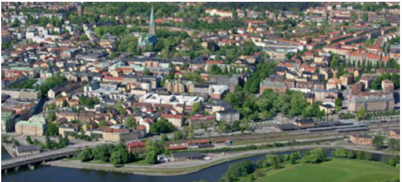
Ostlänken blir Sveriges största samhällsutvecklingsprojekt och Sveriges första höghastighetsjärnväg.
