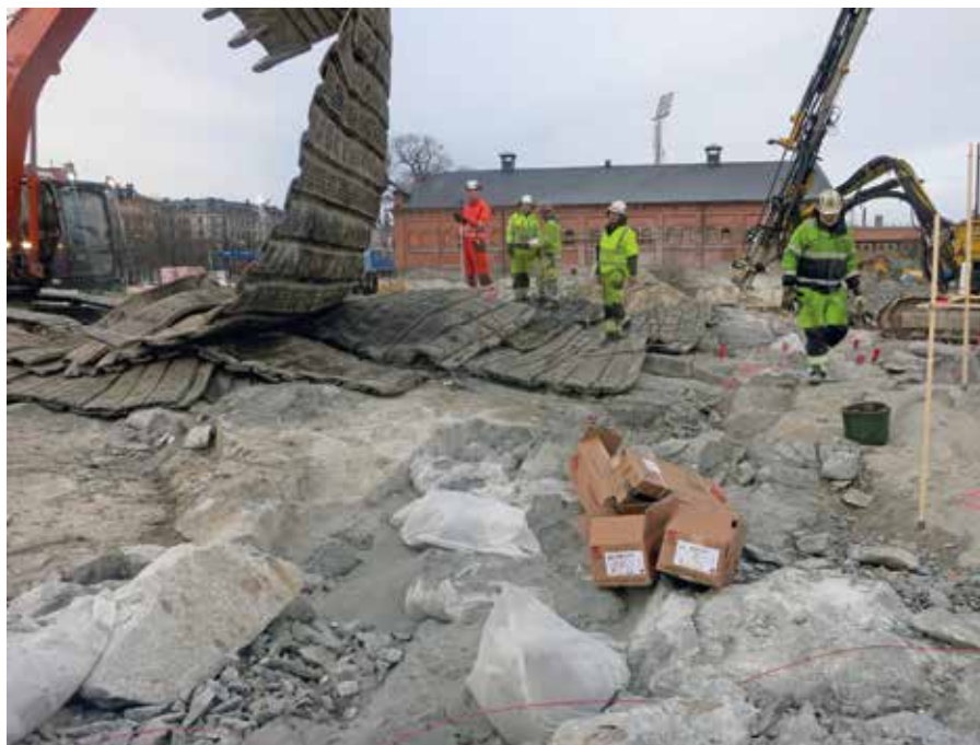
RG täcker inför dagens första sprängning.
