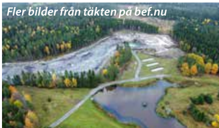
Längst ned uppsamlingsdammen, ovanför syns de tre sedimentationsdammarna och rampen ned till första pallbotten. Området där brytningens skall fortsätta är med råge avbanat.
