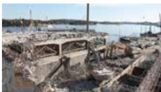
Rivningarna av Östra Slussen pågår för fullt.
