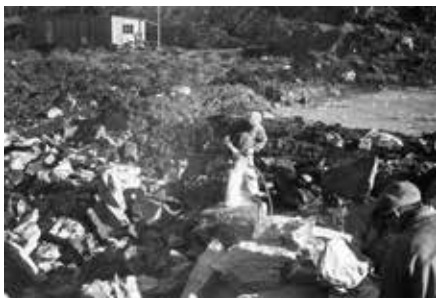
Handhållen borrhning av skut. Kurt berättade att det inte var ovanligt med 10 000 skut som skulle sprängas. Tidsödande och hårt arbete. Dagens förfinade laddningsteknik ger mycket få skut.
