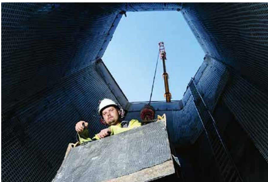
När det regionala bolaget Gryaab behövde en evakuerings-tunnel till sin befintliga tunnel i Röda Sten i Göteborg, gick uppdraget till Bohus Bergsprängning.
