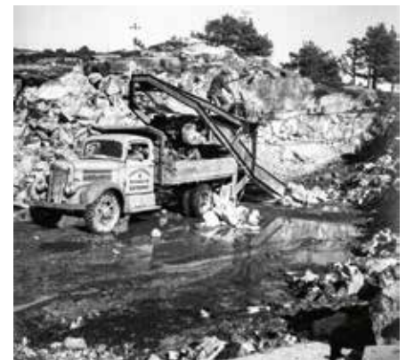
Utskopningen sker med skrapspel kopplat till en Ford "Kick Fire" 1946, vanlig som brandbil. Linorna i spelet löpte genom öglor borrade i berget.
