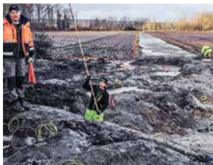
November 2014. Första salvorna för den två km långa transportvägen. Ingen lättjobbad terräng.
