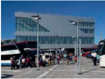
Den nya terminalen är 16 000 kvadratmeter stor med fyra våningar. Foto: Stockholms Hamnar Per-Erik Adamsson Källa Byggvärlden
