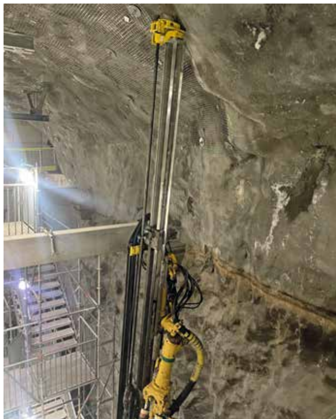
Specialbyggd borrhög för bergförstärkning som kan nå 17 meters höjd.
