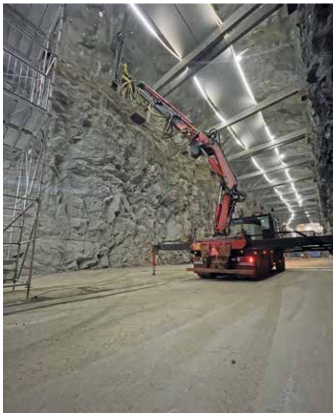
Specialbyggd borrhög för bergförstärkning som kan nå 17 meters höjd.
