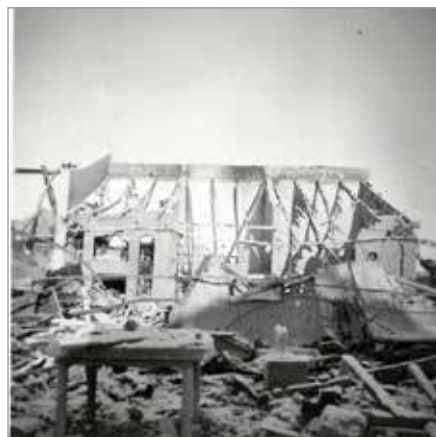
Hexyl-m.m. fabrik från söder. Platskjul i förgrunden.
