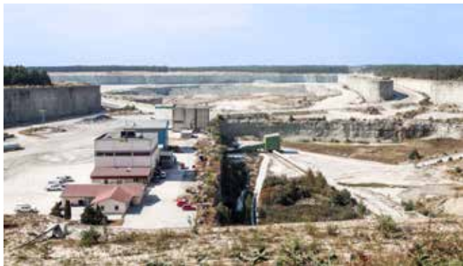
Västra brottet Slite. Bilden till vänster är från 2015 och till höger från 2021. Efter att brytningen av andra pallen avslutades 2017 har en sjö växt fram. Den innehåller redan 2 miljoner m 3 vatten. Färdigbrutna kalkbrott är djupa och har branta kanter. De lämpar sig betydligt bättre som vattenmagasin än de grunda träsk man nu hämtar dricksvatten från.
