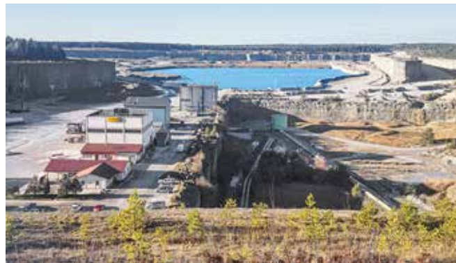
Västra brottet Slite. Bilden till vänster är från 2015 och till höger från 2021. Efter att brytningen av andra pallen avslutades 2017 har en sjö växt fram. Den innehåller redan 2 miljoner m 3 vatten. Färdigbrutna kalkbrott är djupa och har branta kanter. De lämpar sig betydligt bättre som vattenmagasin än de grunda träsk man nu hämtar dricksvatten från.
