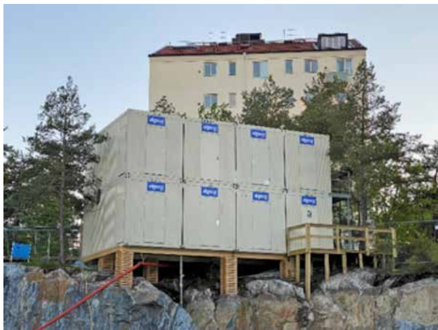
Bild 1. Elegant grundlagda byggbodnar på slänkrönet till en fint utsprängd och rensad bergvägg. Vid sprängningsarbeten kan diskussionerna vara intensiva om bergets vibrationsöverföring, så kallade K-värden. Alltför ofta baseras dock diskussionerna om vad som bestämmer K-värden på felaktigt synsätt.
