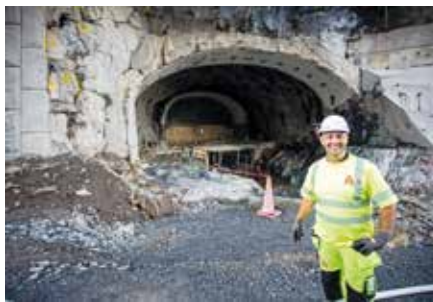
Gamla tunneln in till OK-garaget vid Katarinvägen. Foto: Anette Broman.
