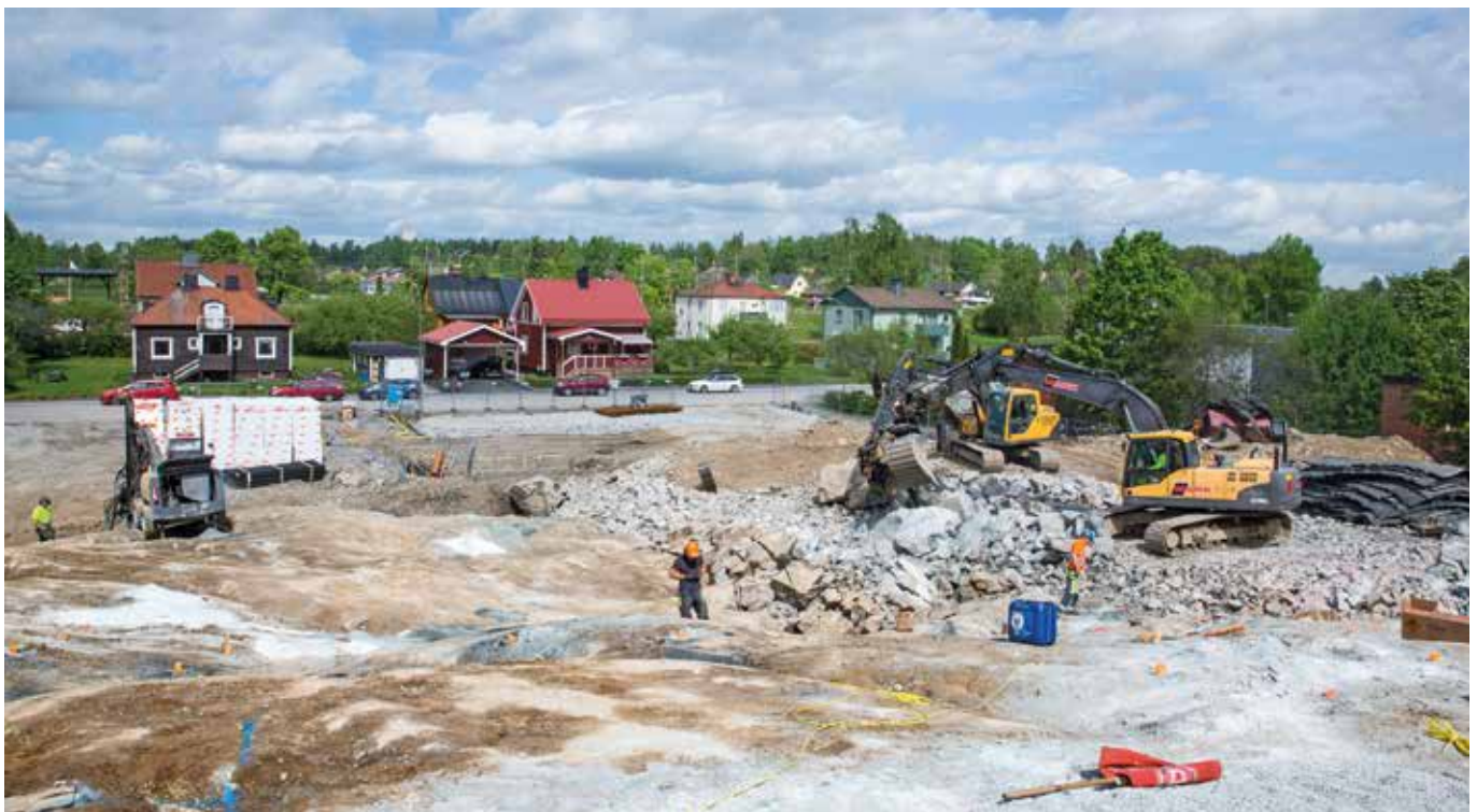
Daniel Wirenborg borrar. Albin Wärnelid och Olle Wärnqvist laddar. Massorna körs ut efter senaste sprängningen för en hissrop. Boningshus ligger på alla sidor om arbetsplatsen. Järnvägen skymtar i bakgrunden.
