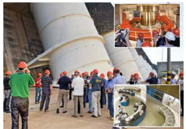
Tilloppstuberna med innerdiameter 10,5 m levererar 700 km 3 vatten per sekund till turbinerna. Övre inf. bilden visar en turbinaxel, turbinen finns i våningen under. Nedre inf. bilden visar kontrollrummet där Paraguay och Brasilien har var sin avdelning. Elen delas lika mellan länderna. Paraguay klarar hela landets förbrukning på 10 procent av sin andel, resten säljs till Brasilien.
