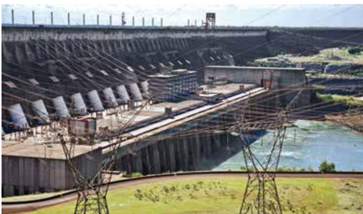
Det imponerande vattenkraftverket Itaipu i gränsområdet Brasilien/Paraguay. Paranaflodens jämna flöde året runt gör att Itaipu med 14 000 MW installerad effekt kan leverera fantastiska 94 TWh. Mer än Three Gorges som trots installerade 18 000 MW "bara" får ut 84 TWh pga. Yang-Tse-flodens varierande flöde. Tack vare ABBs HVDC-teknik är det rekordsmå förluster i elnätet de 90 milen till São Paulo
