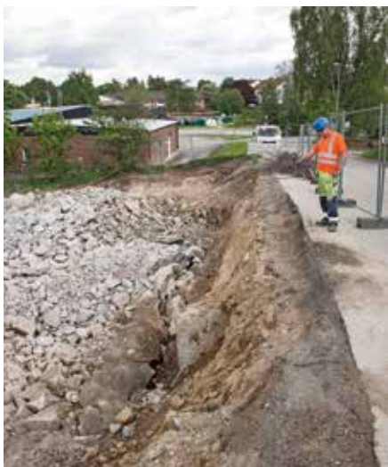
Tätsöm mot Gruvgränd, sprängt med 30 cm mellan hålen i stället för 120 cm.
