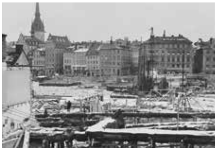
Pålningsarbeten 1932, Okänd, Stockholmskällan.
