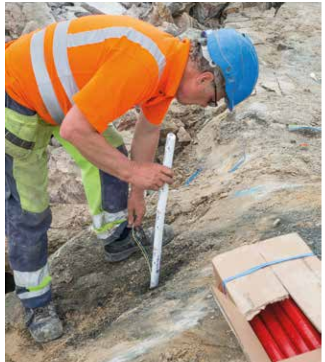
Pipladdningen åker ned.
