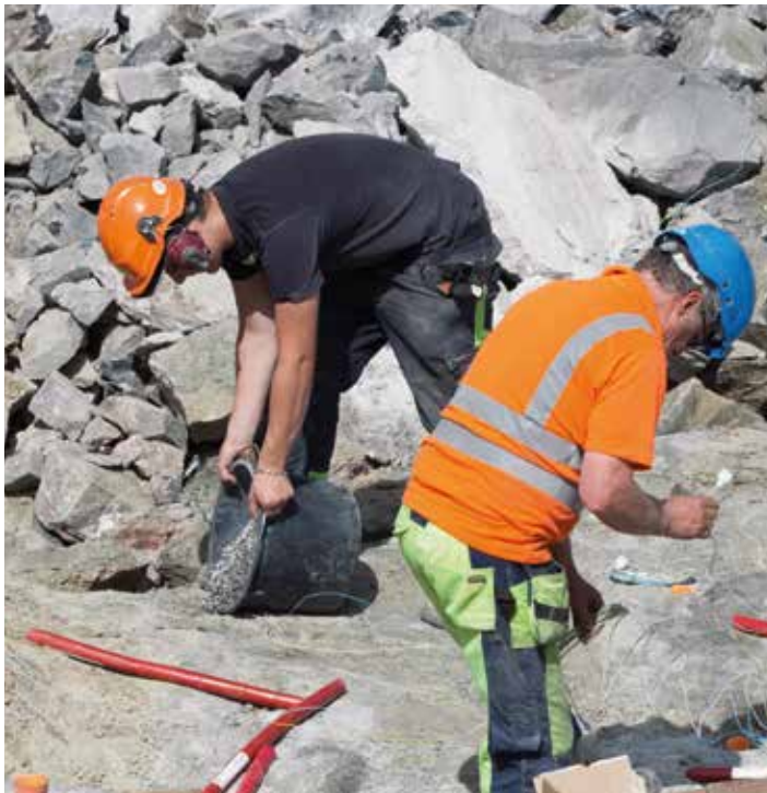
Albin avslutar ett hål med sandproppen medan Olle apterar klassisk nitroglycerindynamit.
