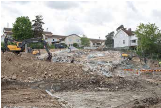
Juni 2017. I bakgrunden befintligt äldreboende med 54 lägenheter. En gångtunnel över vägen ska byggas till de nya huskropparna.
