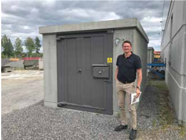
Bild visar betongkassun med möjlighet att bygga ut, sk. modullösning.
