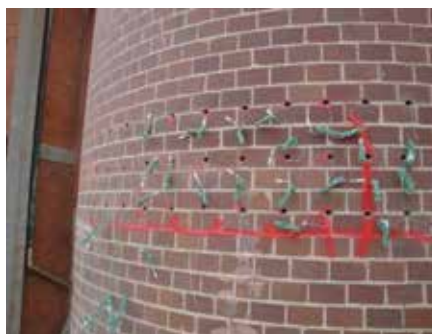
Tätt borrar vid sprängning av skorsten!
