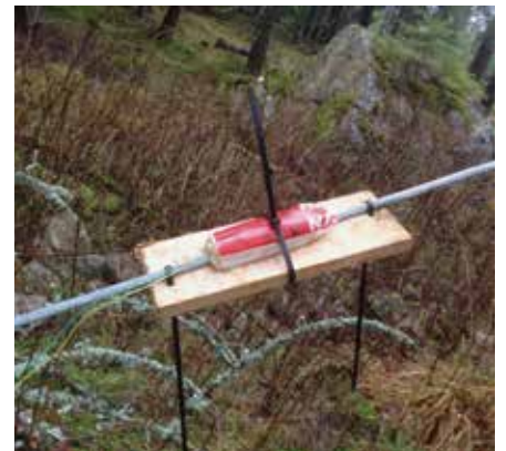
När vi apterar vajrarna används huvudsakligen plastisk sprängdeg, Den har högre detonationshastighet än dynamit (tänk karateslag) ca 200g / vajer.
