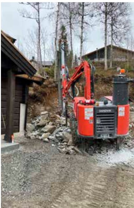
Spränga går bra även nära byggnader.
